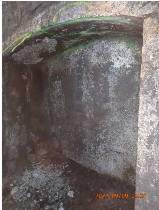
Foto Nr. 7: km 14'379 (Zone 5), Parament links, Nische, Hohlstelle, Abplatzung, Feuchstellen, Ausblühungen
