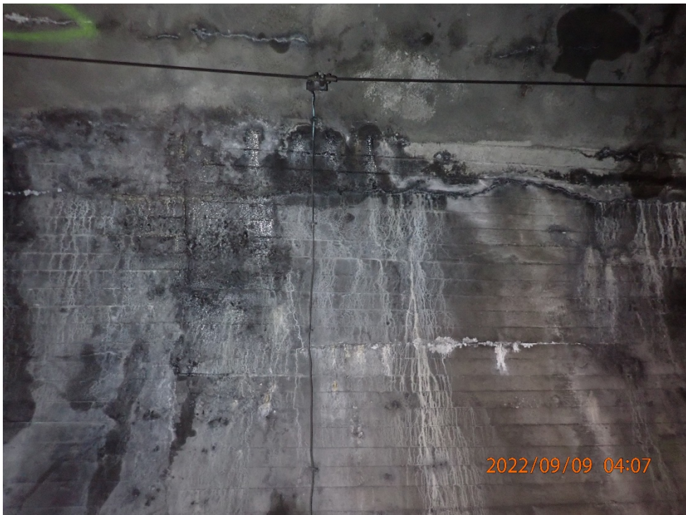
Foto Nr. 9: km 14'411 (Zone 8), Parament und Kämpfer rechts, Risse, Nassstelle, Ausblühungen
