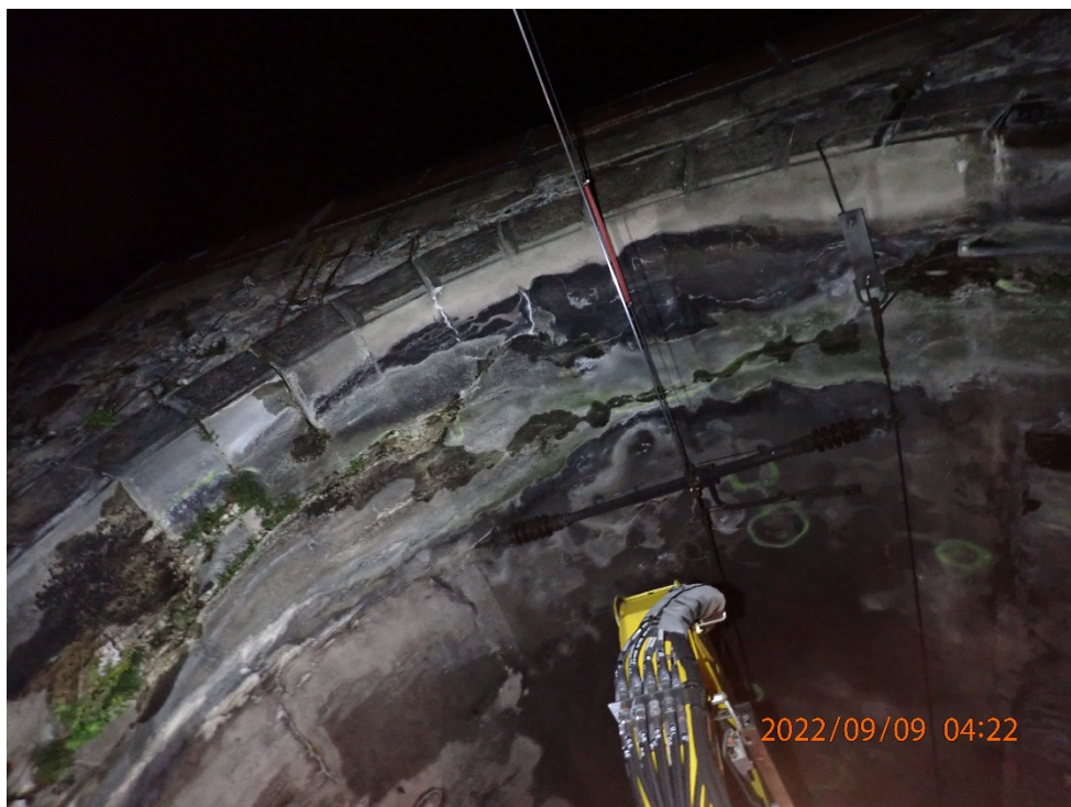
Foto Nr. 11: km 14'429 (Zone 10), Parament rechts, aufgelöstes Mauerwerk, Hohlstelle, Abplatzung, leere Fugen, Rissfläche, Ausblühungen, Pflanzenbewuchs
