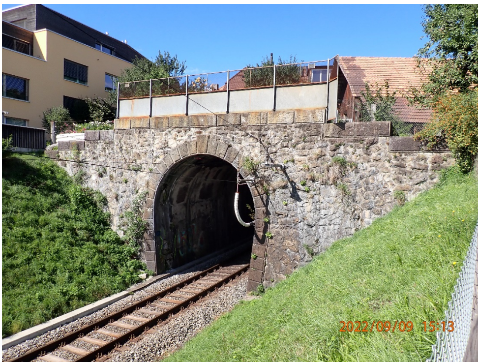
Foto Nr. 1: Portal Biglen, Hohlstellen, Abplatzungen, Risse, Ausblühungen, Pflanzenbewuchs
