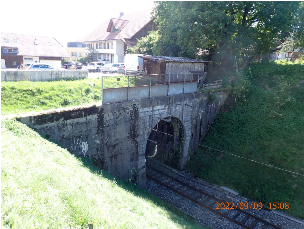
Foto Nr. 1: Portal Biglen, Hohlstellen, Abplatzungen, Risse, Ausblühungen, Pflanzenbewuchs
