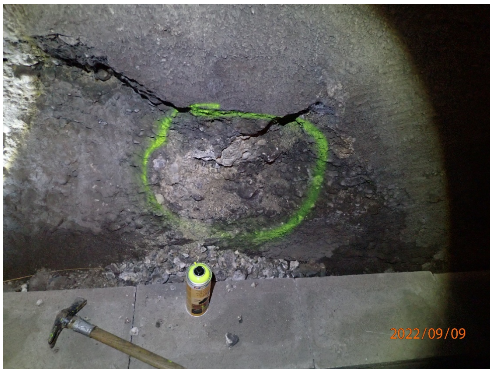
Foto Nr. 7: km 14'379 (Zone 5), Parament links, Nische, Hohlstelle, Abplatzung, Feuchstellen, Ausblühungen
