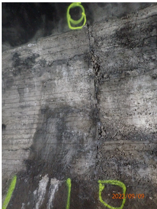
Foto Nr. 5: km 14'336 (Zone 1), Kämpfer links / First, klaffender Riss, Hohlstelle, zugesinterte Rissfläche, Pflanzenbewuchs (Moos)
