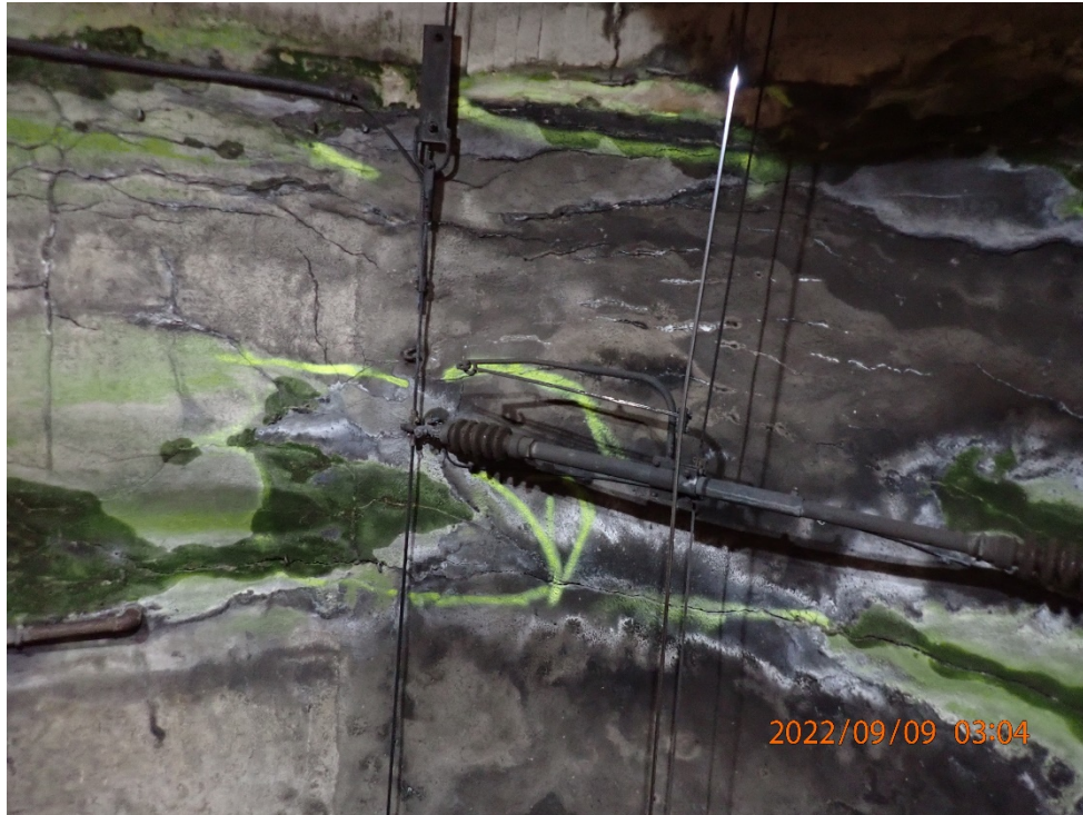
Foto Nr. 5: km 14'336 (Zone 1), Kämpfer links / First, klaffender Riss, Hohlstelle, zugesinterte Rissfläche, Pflanzenbewuchs (Moos)
