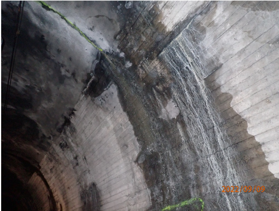
Foto Nr. 9: km 14'411 (Zone 8), Parament und Kämpfer rechts, Risse, Nassstelle, Ausblühungen
