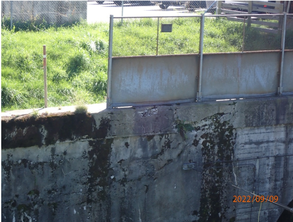
Foto Nr. 3: Portal Biglen, Hohlstellen, Abplatzungen, Risse, mürber Beton, Pflanzenbewuchs
