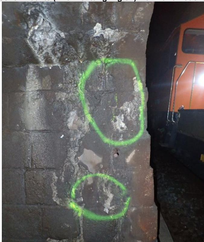
100 ca. km 13'964, Nische 1 rechts (Blickrichtung Biglen) Hohl- und Feuchtstellen
