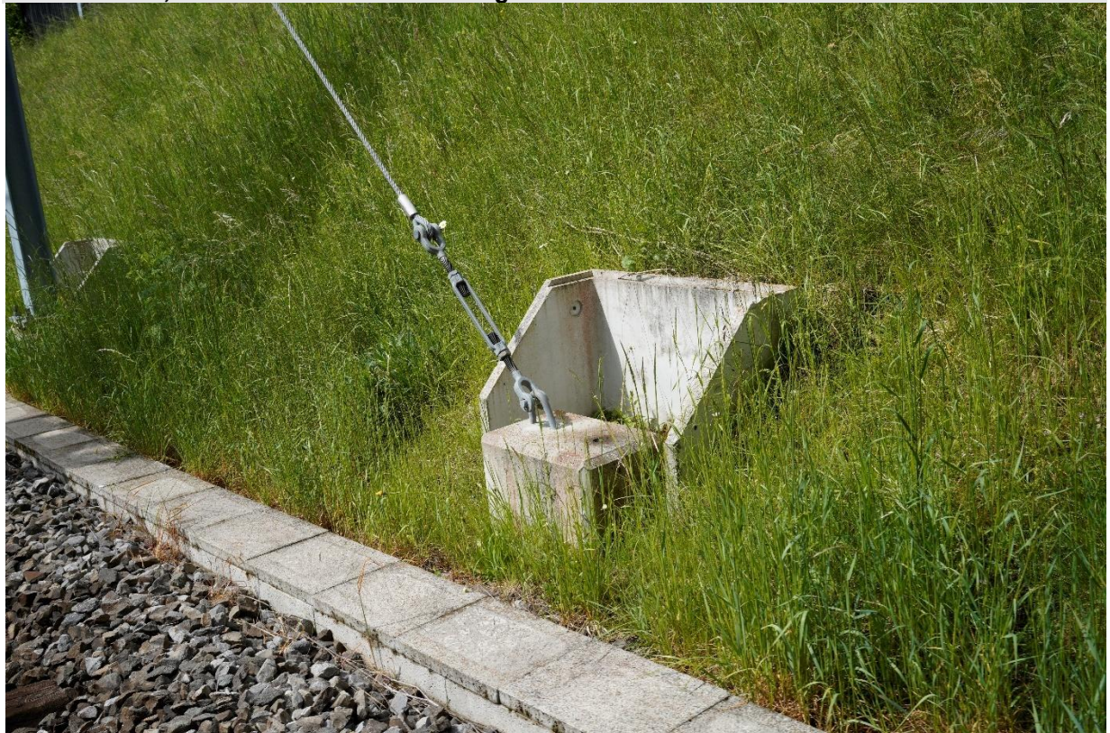
50 km 14'400, Detailaufnahme Verankerung Strommast bei Gleis
