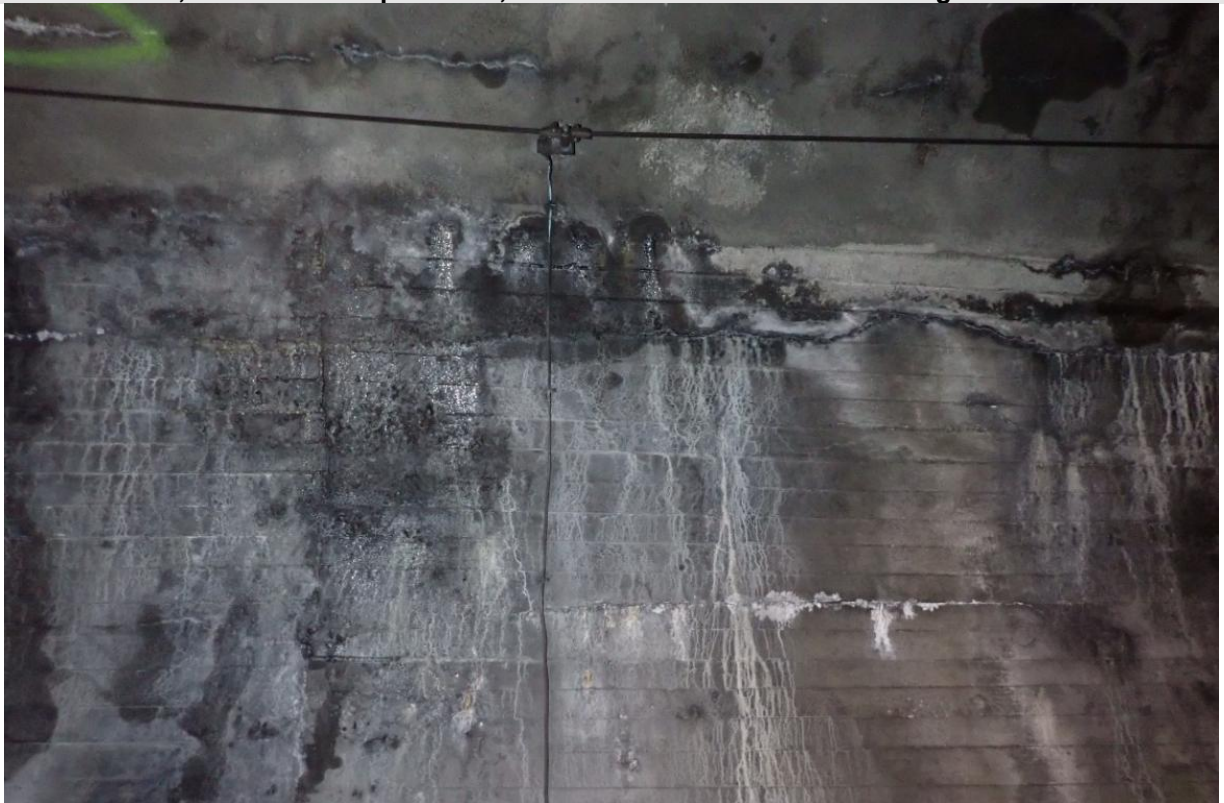
111 km 14'429 (Portal GHS), Parament rechts; defektes Mauerwerk
