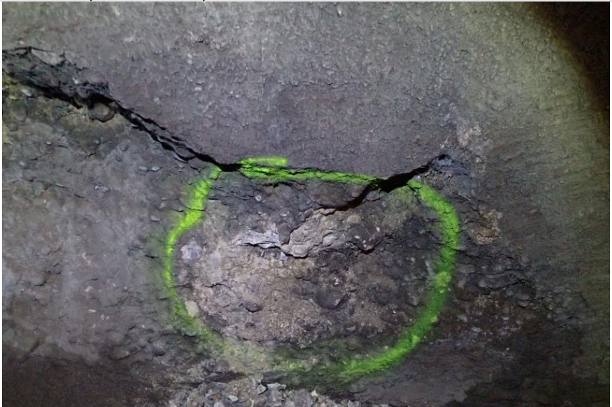
109 km 14'411, Parament/Kämpfer rechts; Risse/Nassstellen mit Ausblühungen
