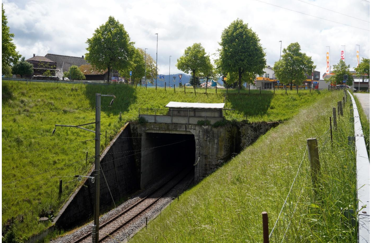
79 km 13'800, GHT1 Nordportal von oben mit Kreisel
