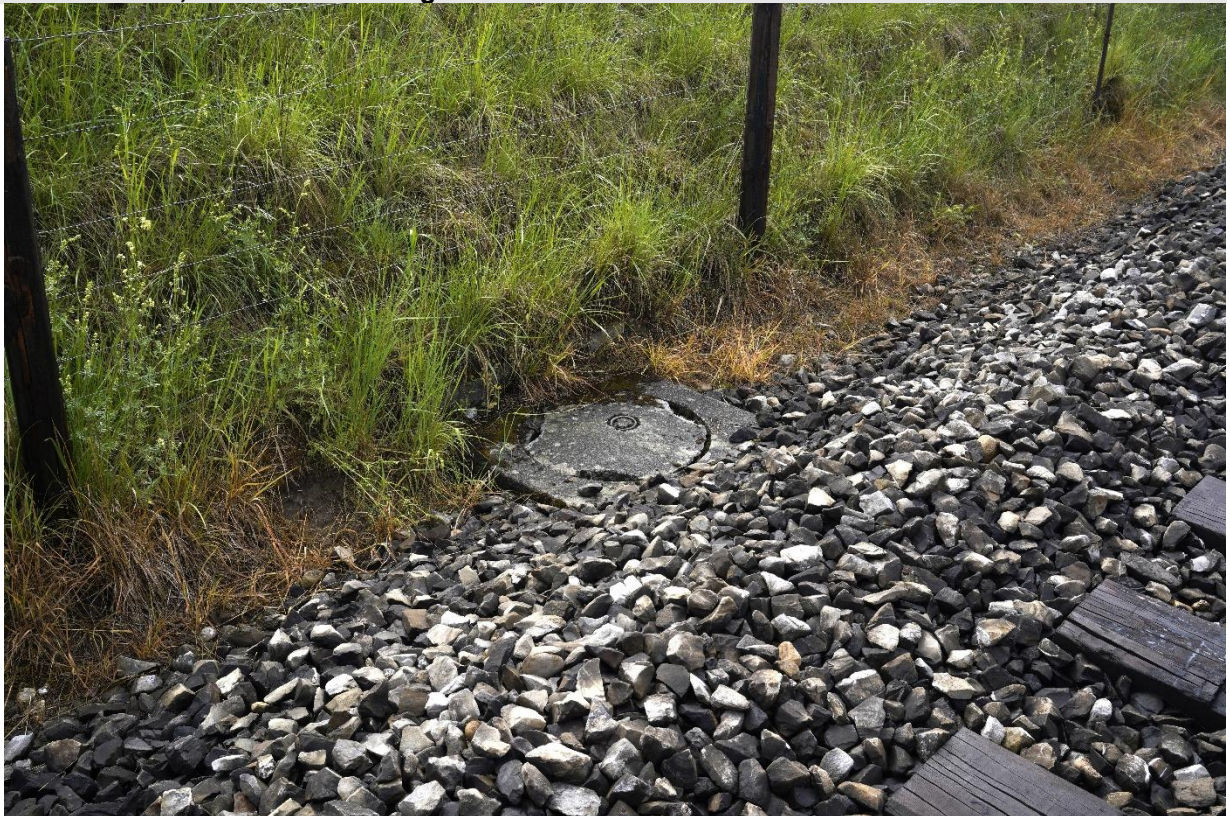
13 km 13'500, Schacht linksseitig
