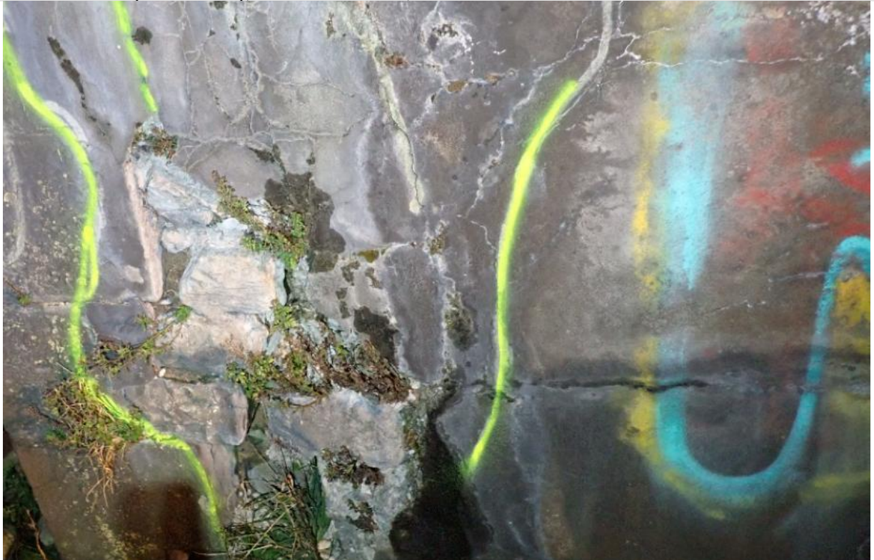
111 km 14'429 (Portal GHS), Parament rechts; defektes Mauerwerk
