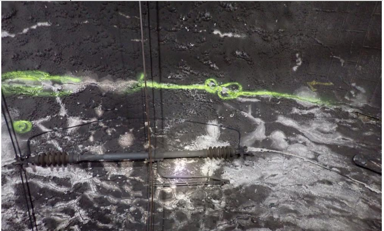
98 ca. km 13'916, Firstbereich mit klaffendem Riss
