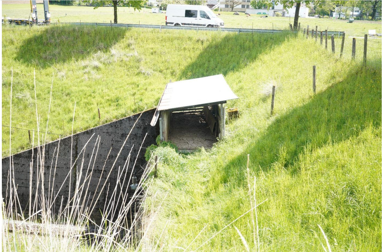
80 km 13'900, Oberseite GHT1 Nordportal mit Unterstand
