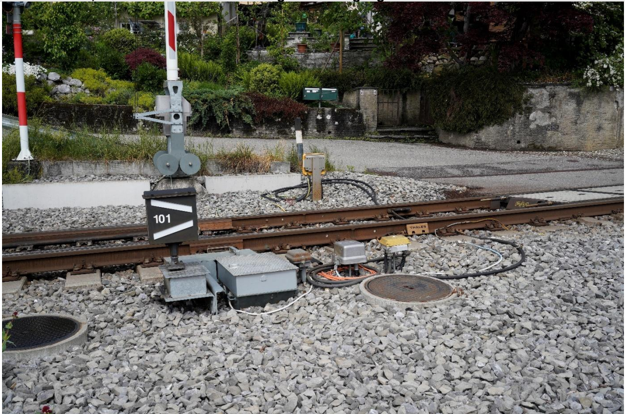
58 km 14'500, Detailaufnahme Verkabelung Bahnübergang
