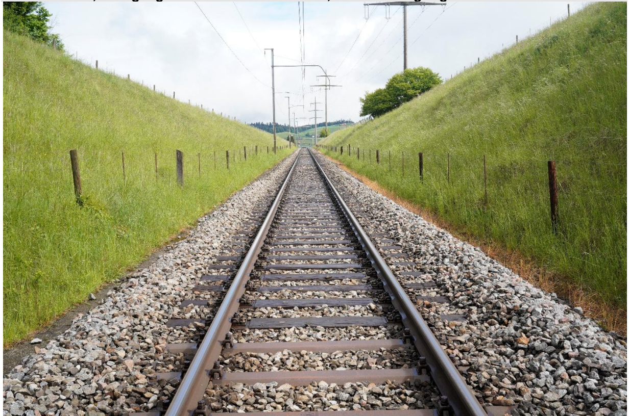
23 km 13'700, Übergang Holz- zu Metallschwellen, Blickrichtung Biglen
