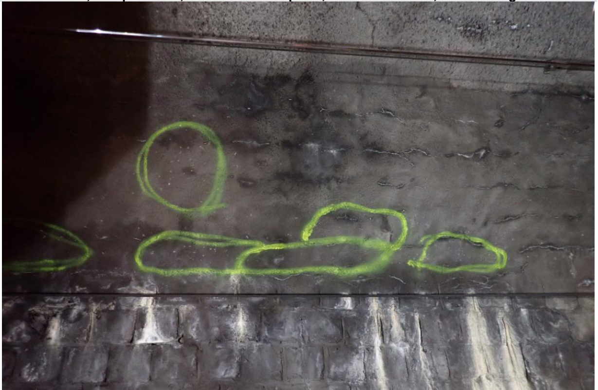
102 km 13'992, Kämpfer links; Hohlstellen im SprüBe, versinterte Risse, Ausblühungen
