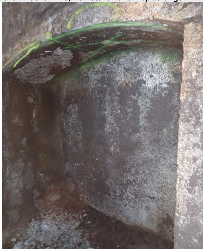
107 km 14'379, Parament / Nische links, Hohlstellen und Abplatzungen
