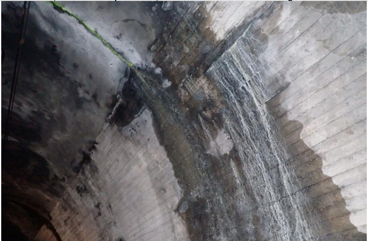
109 km 14'411, Parament/Kämpfer rechts; Risse/Nassstellen mit Ausblühungen
