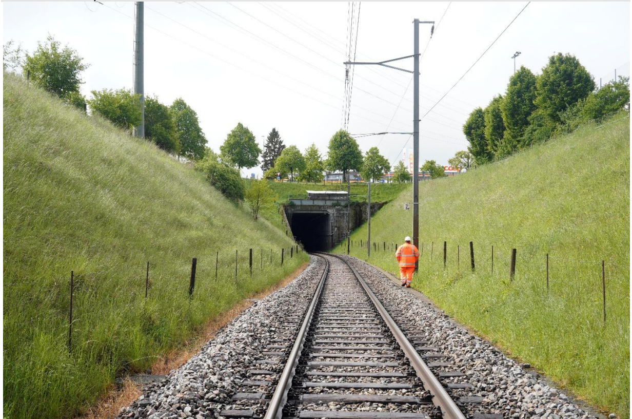
23 km 13'700, Übergang Holz- zu Metallschwellen, Blickrichtung Biglen
