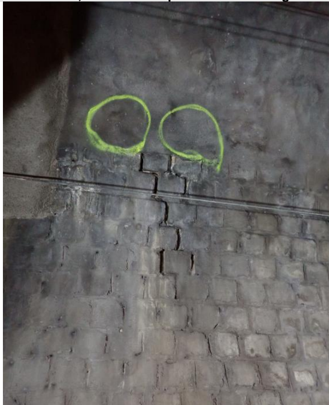
100 ca. km 13'964, Nische 1 rechts (Blickrichtung Biglen) Hohl- und Feuchtstellen
