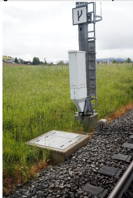
7 km 13'400, Signalkasten 1345 und Kabelquerung, Kabelverteilkasten 1346
