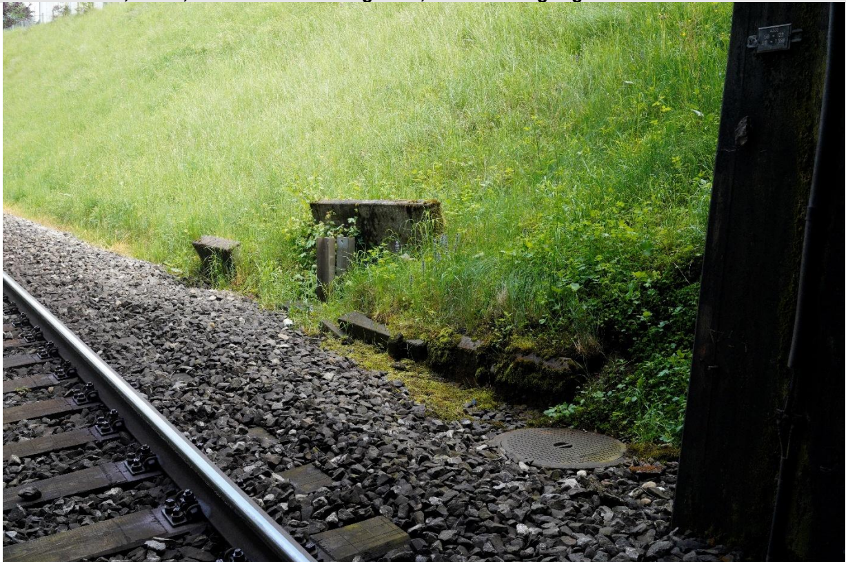
45 km 14'300, GHT2, Nordseite Böschung links, Blickrichtung Biglen
