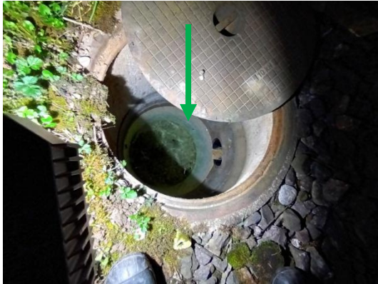
ID-Nr. 10: Die Entwässerung besteht aus unverdächtigen Beton- / Kunststoffrohren.
