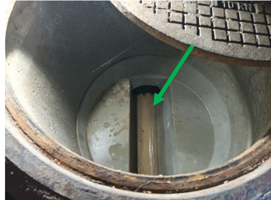
ID-Nr. 10: Die Entwässerung besteht aus unverdächtigen Beton- / Kunststoffrohren.
