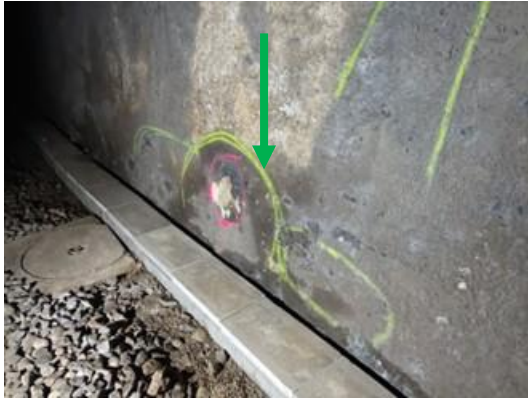
ID-Nr. 02: asbestfreier Putz / Spritzbeton, der PFAS Anteil liegt unterhalb der Bestimmungsgrenze
