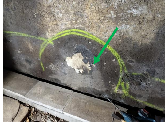
ID-Nr. 02: asbestfreier Putz / Spritzbeton, der PFAS Anteil liegt unterhalb der Bestimmungsgrenze
