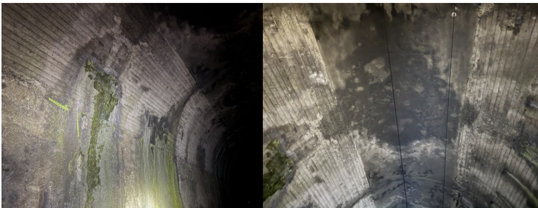
Abbildung 7-8: GHT II: Bestandesaufnahme im Firstbereich und im seitlichen Tunnelbereich.
