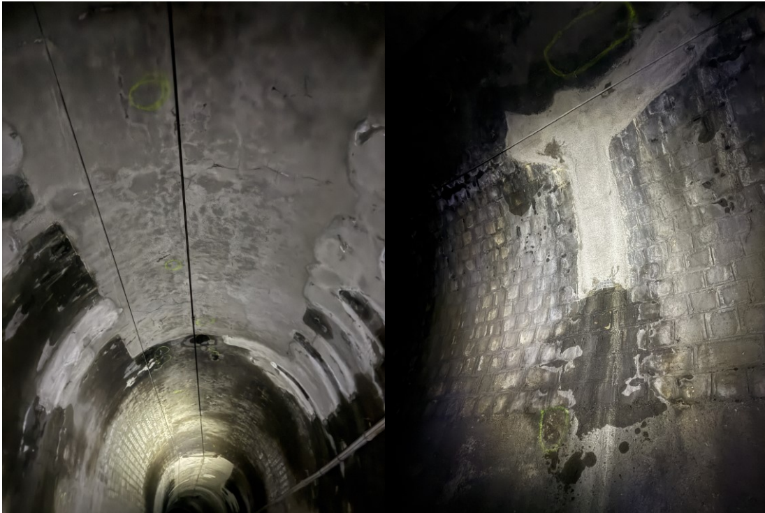
Abbildung 7-7: GHT I: Bestandesaufnahme im Firstbereich und im seitlichen Tunnelbereich.
