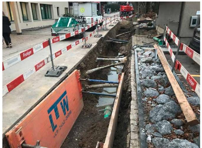
In Zusammenarbeit mit der Firma CKW und der Firma Brancher wurde das alte Mittelspannungskabel durch ein neues Kabel ersetzt. Der Austausch erfolgte in Koordination mit der Wasseranierung in der Kramgasse, wodurch die Kosten für den Tiefbau erheblich reduziert werden konnten.
