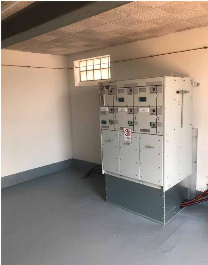
Die alte «offene» Mittelspannungsschaltanlage wurde durch eine moderne Anlage mit geschlossenen Schaltzellen ersetzt.
